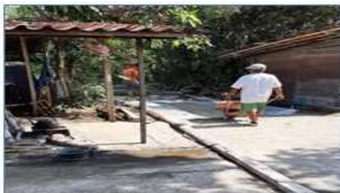
Gambar 9. Pelaksanaan Pengerjaan Pengecoran Beton
