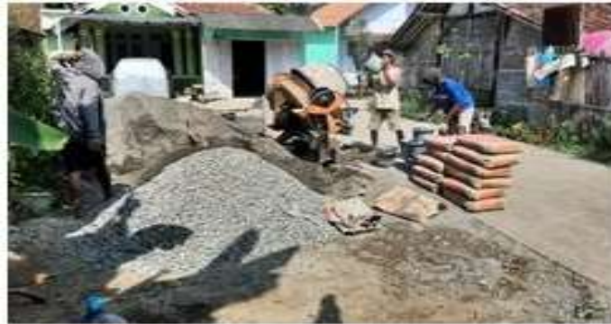
Gambar 8. Proses Pencampuran Beton Menggunakan molen Pengaduk
