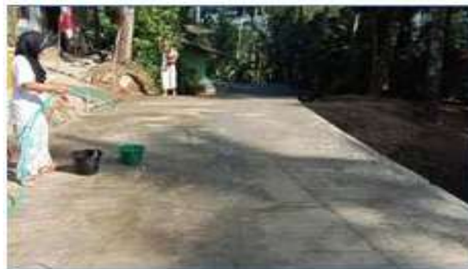
Gambar 11. Penyiraman Air permukaan beton
