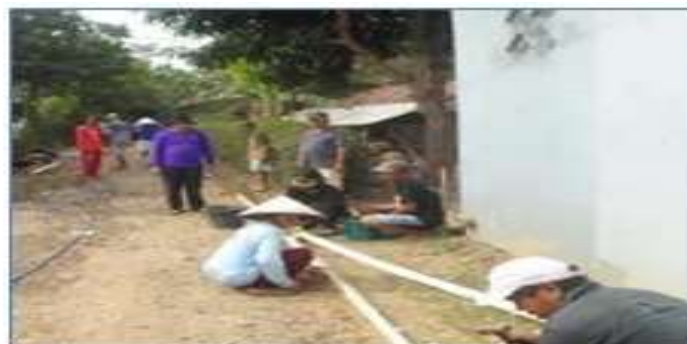
Gambar 6. Pengukuran Lokasi Jalan
