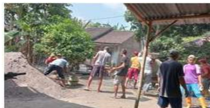
Gambar 7. Pembersihan Lokasi Jalan
