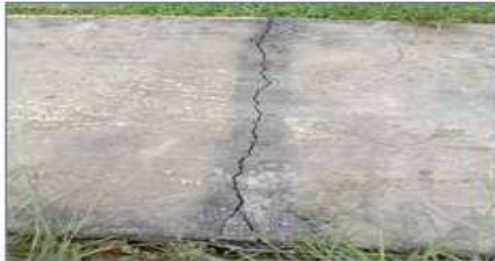
Gambar 10. Retak Plastik Pada beton
