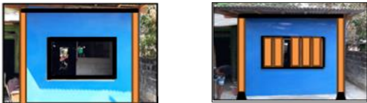
Gambar 9. Bentuk Dan Kondisi Kios Yang Sudah Selesai
