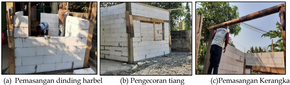
Gambar 8. Tahapan Pembangunan Kios
