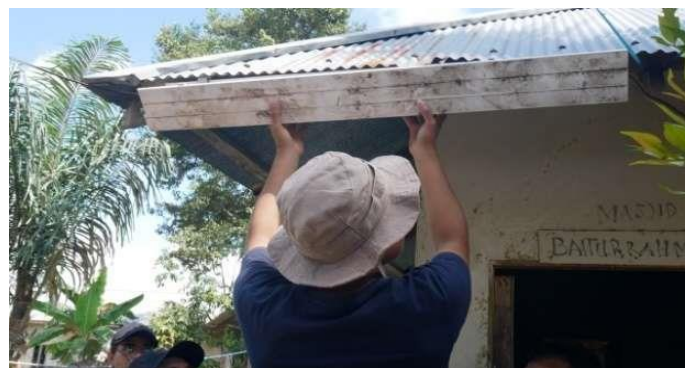
Gambar 5. Proses Pemasangan Talang
